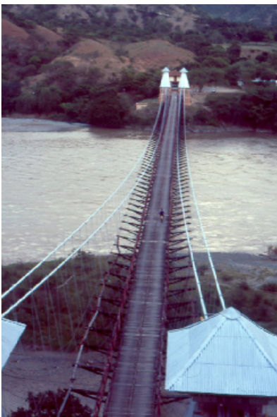
Puente de Occidente Sta. Fé de Antioquia - Antioquia
