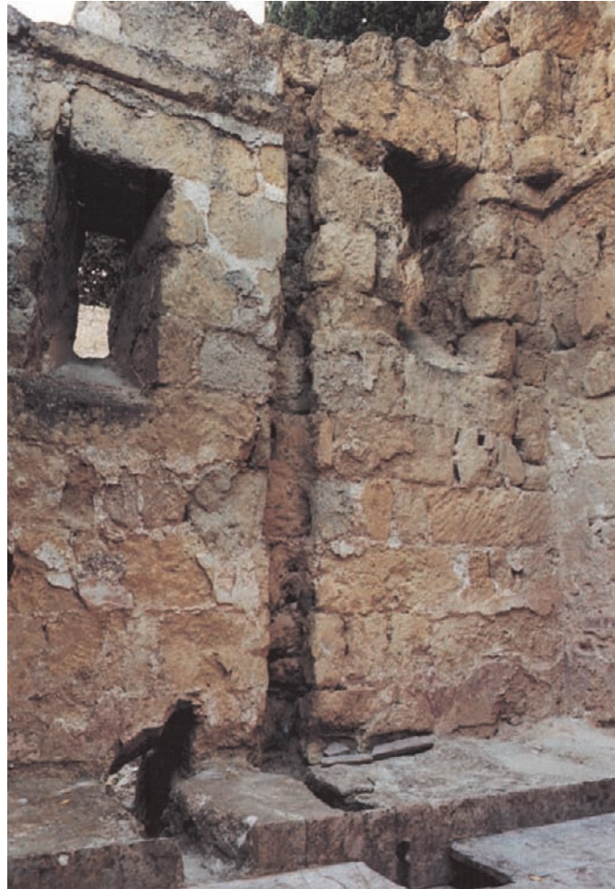
Fig. 8 Madīnat al-Zahrāʾ, Alcazar, latrine
